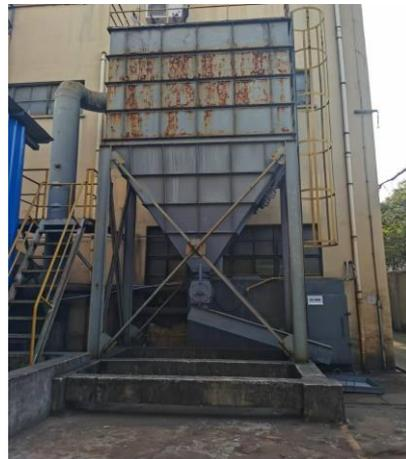
例如：吸附装置应定期更换吸附材料，确保吸附材料的吸附效能；布袋除尘器应定期更换滤袋，确保完整无破损；RTO装置定期检查燃烧器、蓄热体、切换阀等组件，确保系统安全、稳定运行。
