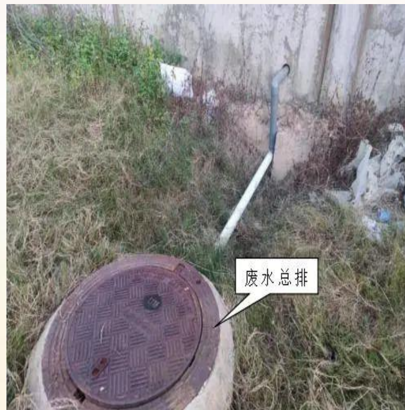
另设管道排放
